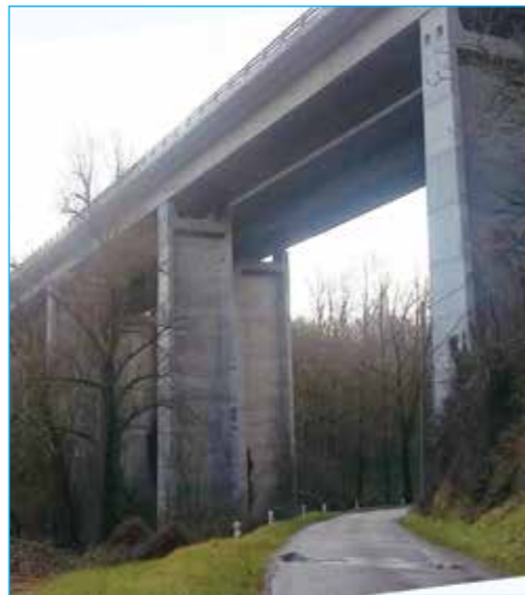
Le pont actuel au-dessus de la vallée de Courtineau
