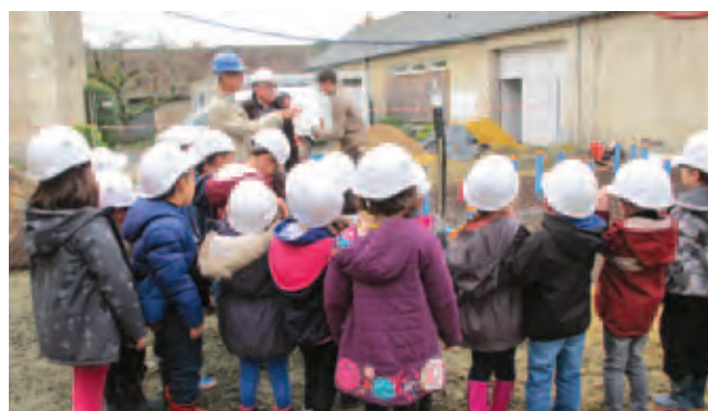
M. Pascal Perrin-Houdon, architecte des travaux, présente les travaux aux enfants.
